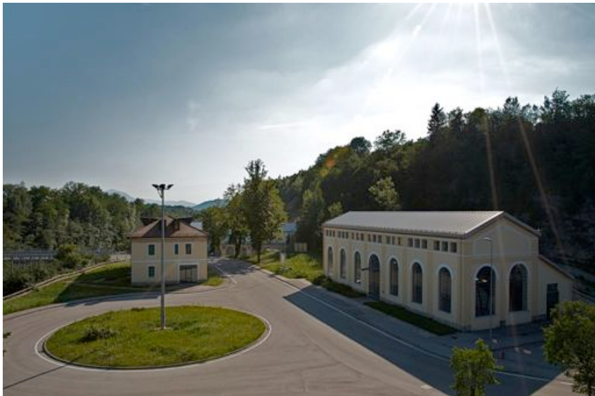
sass muss – il complesso dal tetto del padiglione schiara
