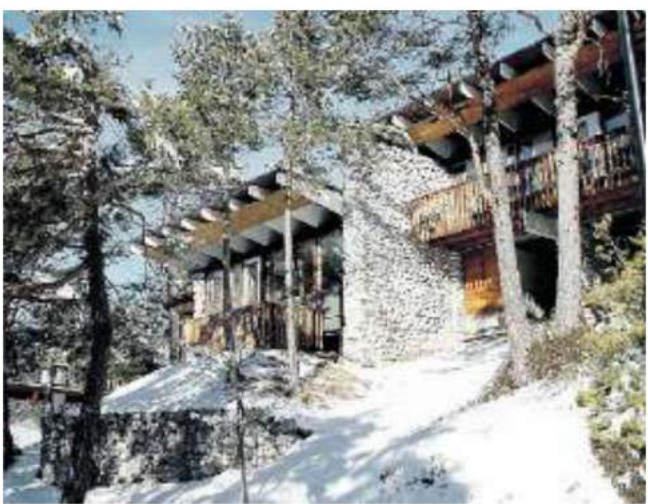
LE STRUTTURE Le villette del Villaggio Eni a Borca di Cadore
