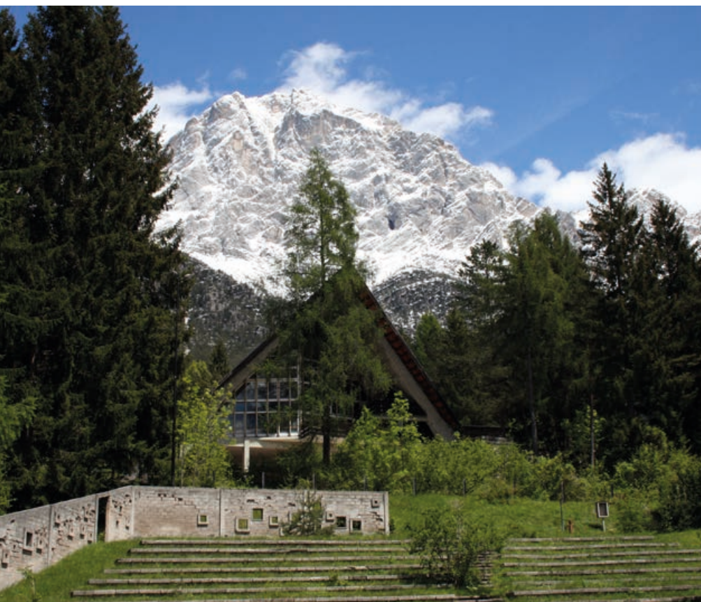
Edoardo Gellner, ex Villaggio ENI a Corte di Borca di Cadore, Belluno (1954-62). Gli spazi della Colonia e del Villaggio turistico realizzati per i dipendenti ENI da Enrico Mattei ed Edoardo Gellner sotto il monte Pelmo sono da anni oggetto di un processo innovativo di riattivazione attraverso l'arte
